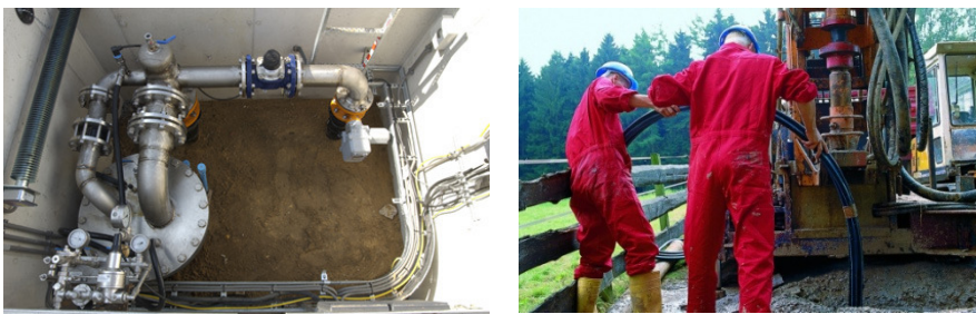
Figuur 2-3 Openbron pompput met bronkop, bron: Redenko / Boren van een monobron, bron: Stiebel Eltron
