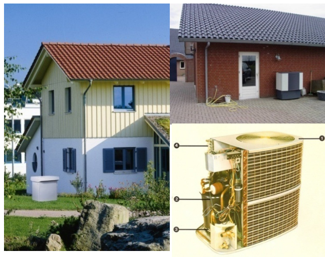
Figuur 3-3 Buitenluchtunit van een lucht/water warmtepomp, bron: Carrier / Stiebel Eltron / Danfos
