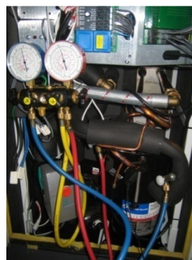
Figuur 5-2 Meten aan een warmtepomp Thermia Duo6 Arvika, bron: Redenko
