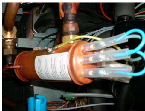
Figuur 3-8 Verwarmingselement met een vermogen van 8,8 kW voor bivalent of Mono-energetisch systeem, bron: Stiebel Eltron
