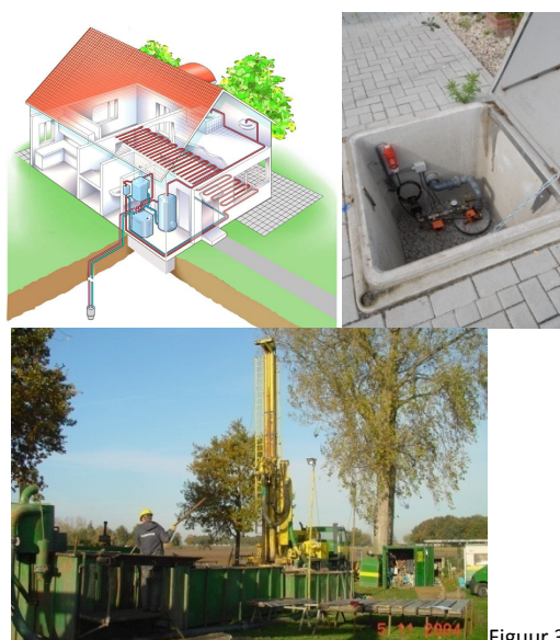
Figuur 3-5 Verticale bodemwarmtewisselaar, bron: Stichting Warmtepompen, Digitale Wegwijzer Warmtepompen / Nibe / Grondboorbedrijf Haitjema B.V.
